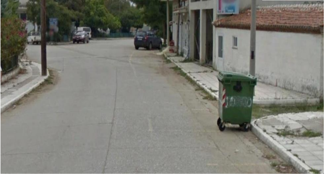
Φωτ. 5: Στρώση κυκλοφορίας από σκυρόδεμα προς αντικατάσταση εντός οικισμού Φιλλύρας
