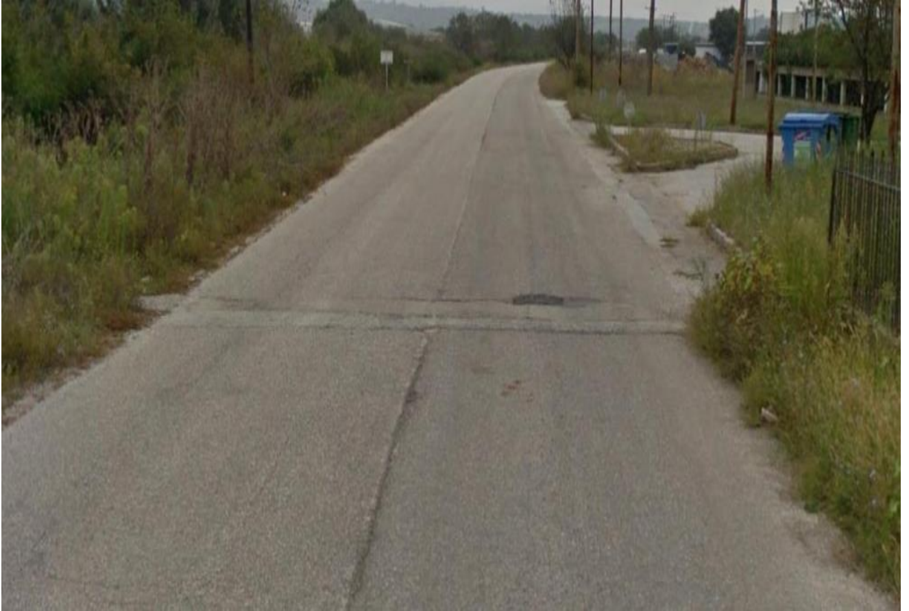
Φωτ. 1: Κακή συναρμογή στρώσεων – μπαλώματα στο ύψος των κτιρίων της εφημερίδας «Παρατηρητή»
