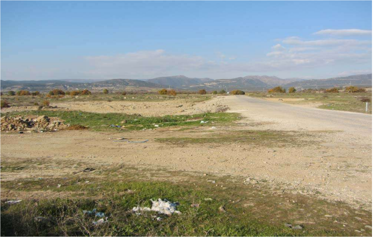
Φωτο 1. Υφιστάμενη ιρλανδική διάβαση Ασπρορέματος. Λήψη από τα βόρεια
