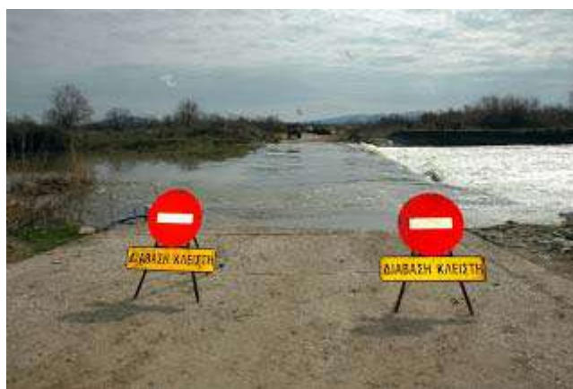
Φωτο 6. Τοποθέτηση σήμανσης για τη διακοπή κυκλοφορίας των ιρλανδικών διαβάσεων
