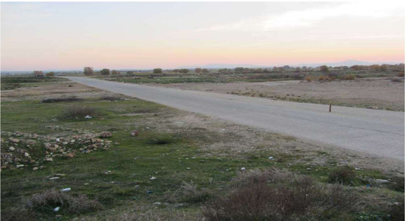
Φωτο 2. Υφιστάμενη ιρλανδική διάβαση Ασπρορέματος. Λήψη από τα νότια
