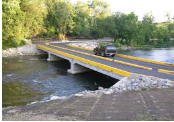
Φωτο 3. Ιρλανδική διάβαση με τοποθέτηση χαμηλού κρασπέδου.
