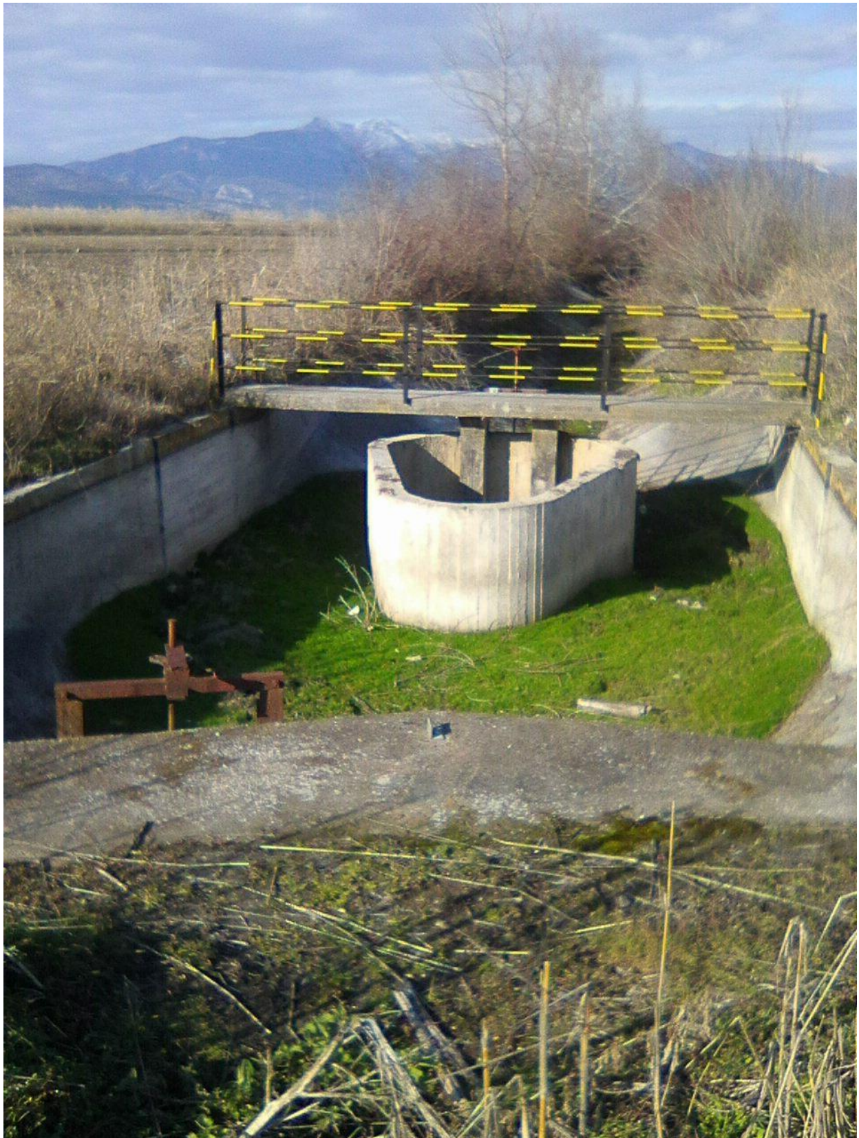
Φωτ. 8: Τερματικό σημείο δυτικής διώρυγας με ανάγκη καθαρισμού. Εντός το ελλειψοειδούς κάτοψης φρεατίου βρίσκεται αγωγός συνεχούς ροής ο οποίος υδροδοτεί ανατολικό υδατόρεμα.
