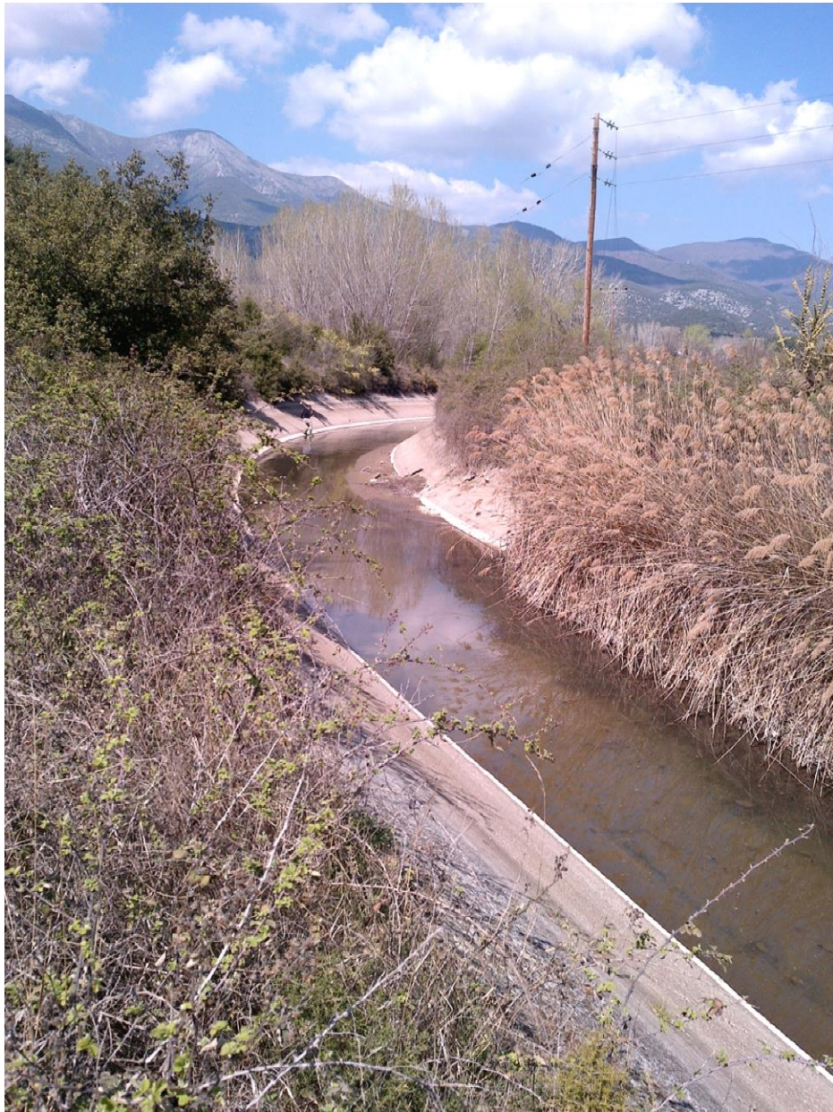
Φωτ.2: Όψη Κεντρικού Προσαγωγού Με Βλάστηση εντός της κοίτης.
