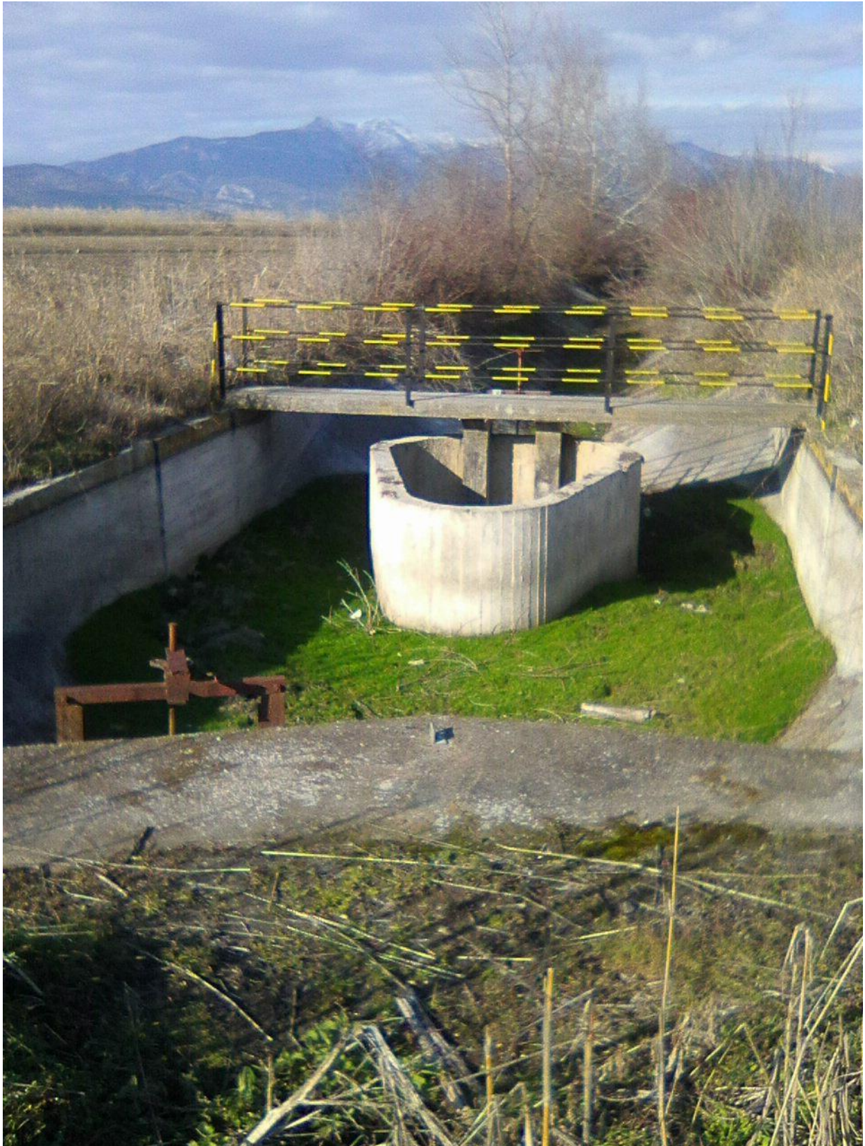
Φωτ. 18: Τερματικό σημείο δυτικής διώρυγας με ανάγκη καθαρισμού. Εντός το ελλειψοειδούς κάτοψης φρεατίου βρίσκεται αγωγός συνεχούς ροής ο οποίος υδροδοτεί ανατολικό υδατόρεμα.
