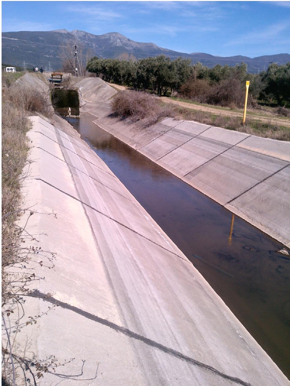
Φωτ. 29: Όψη ανατολικής διώρυγας πλησίον ανισοσταθμίας κατάντη βραχοπαγίδας, η επένδυση αυτής κρίνεται καλή.
