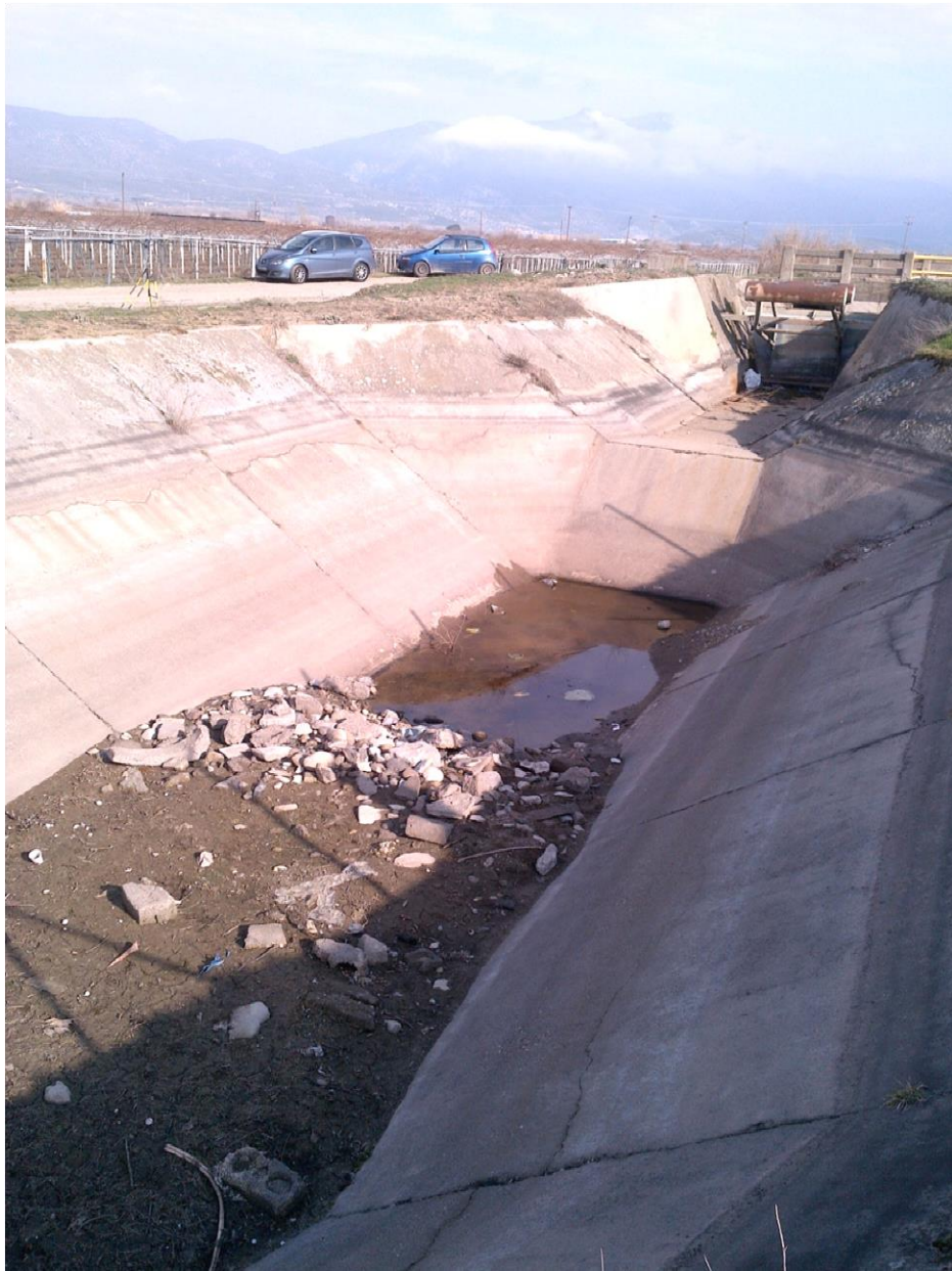
Φωτ. 14: Όψη δυτικής διώρυγας με λήψη εντός της βραχοπαγίδας και του θυροφράγματος.
