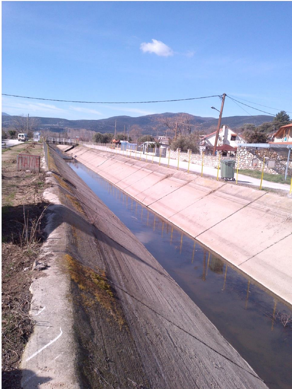
Φωτ. 30: Όψη ανατολικής διώρυγας εντός του οικισμού της Θαλασσιάς. Η επένδυση κρίνεται σε καλή κατάσταση.
