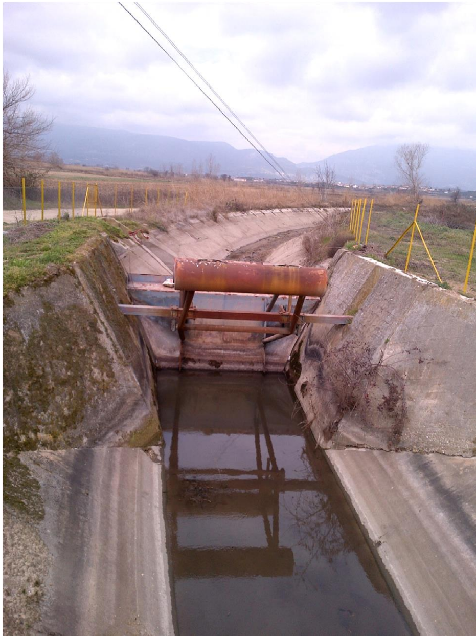
Φωτ. 22: Όψη ανατολικής διώρυγας με το θυρόφραγμα τύπου AMIL εντός αυτής.
