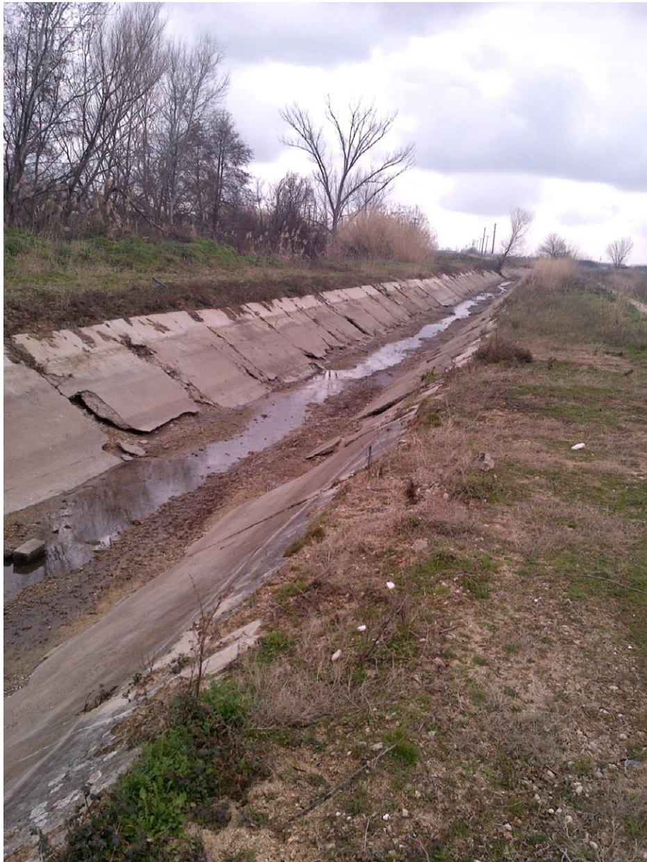
Φωτ. 23: Όψη ανατολικής διώρυγας με ανάγκη καθαρισμού και επανεπένδυσης.
