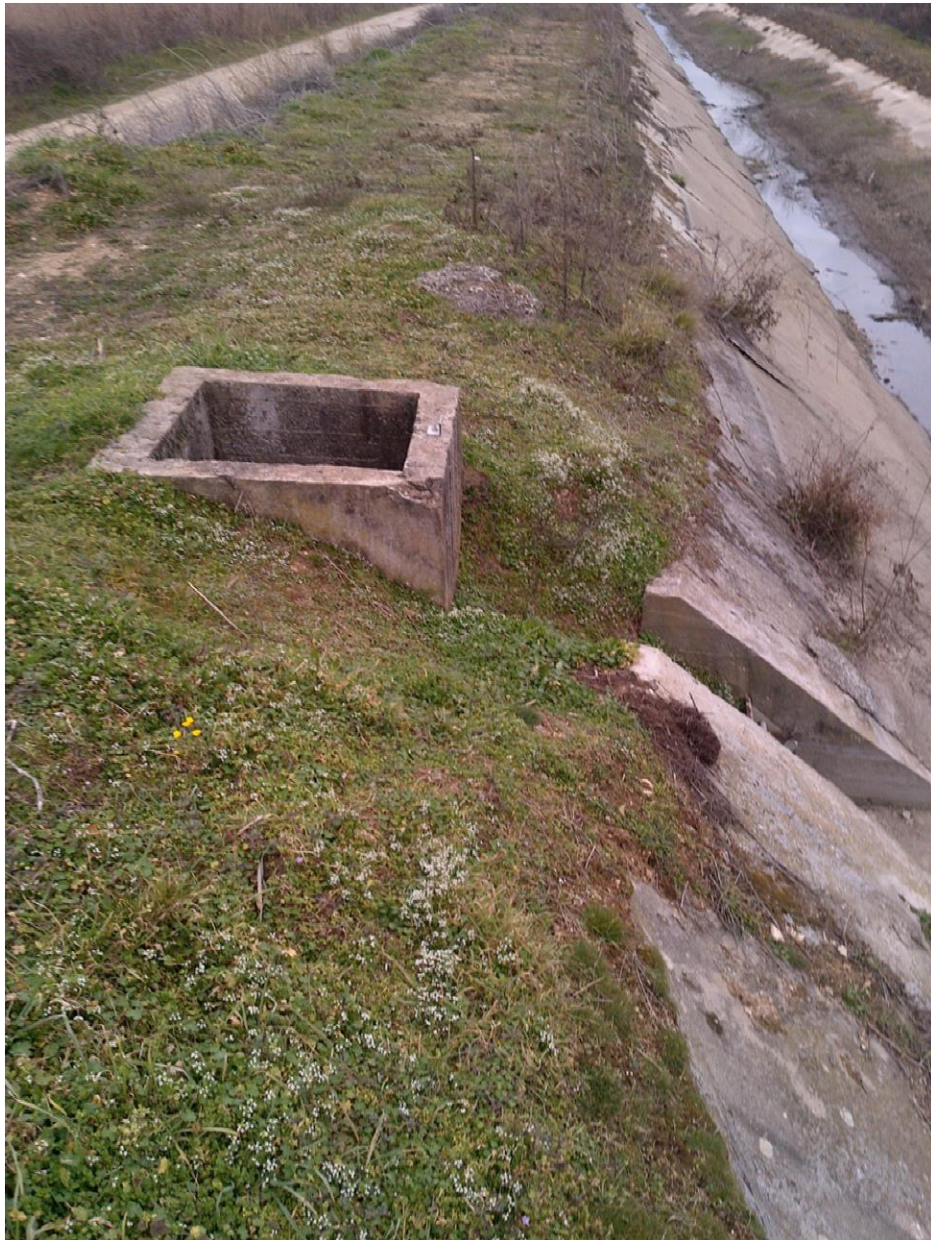
Φωτ. 24: Όψη ανατολικής διώρυγας, εμφανίζεται το εγκάρσιο θυρόφραγμα το οποίο υδροδοτεί το τριτεύων αρδευτικό δίκτυο.
