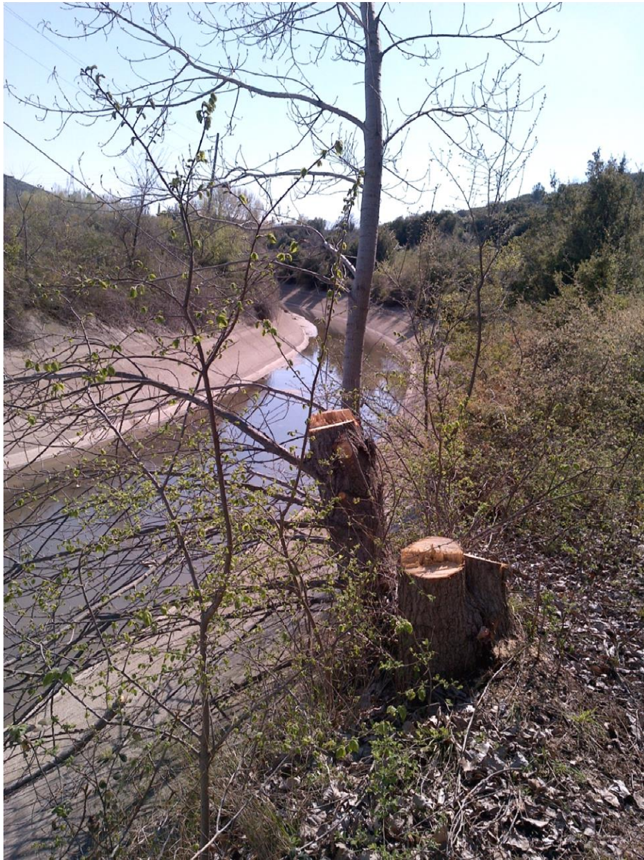
Φωτ. 5: Όψη Κεντρικού Προσαγωγού Με Βλάστηση εντός της κοίτης και σε καλή κατάσταση η επένδυση των πρανών.
