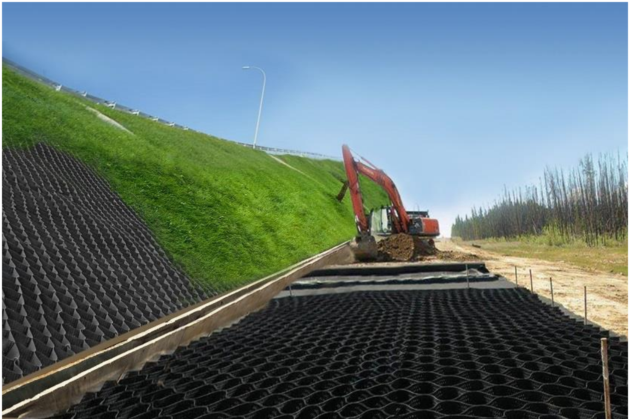
Φωτ 1 - Τοποθέτηση γεωκυψελών στα πρανι
