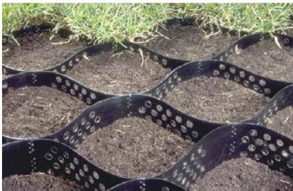
Φωτ 2 - Πλήρωση με φυτική γη
