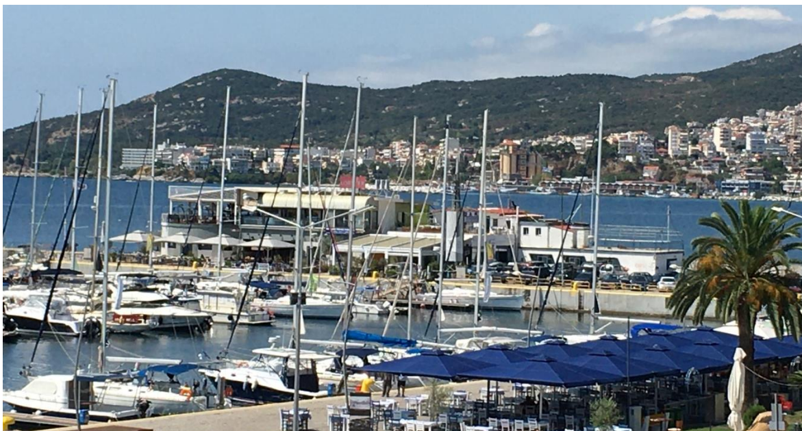
Εικόνα 7: Κτιριακές Εγκαταστάσεις Υπήνεμου μόλου - Πηγή: Αρχείο ΟΛΚ Α.Ε.
