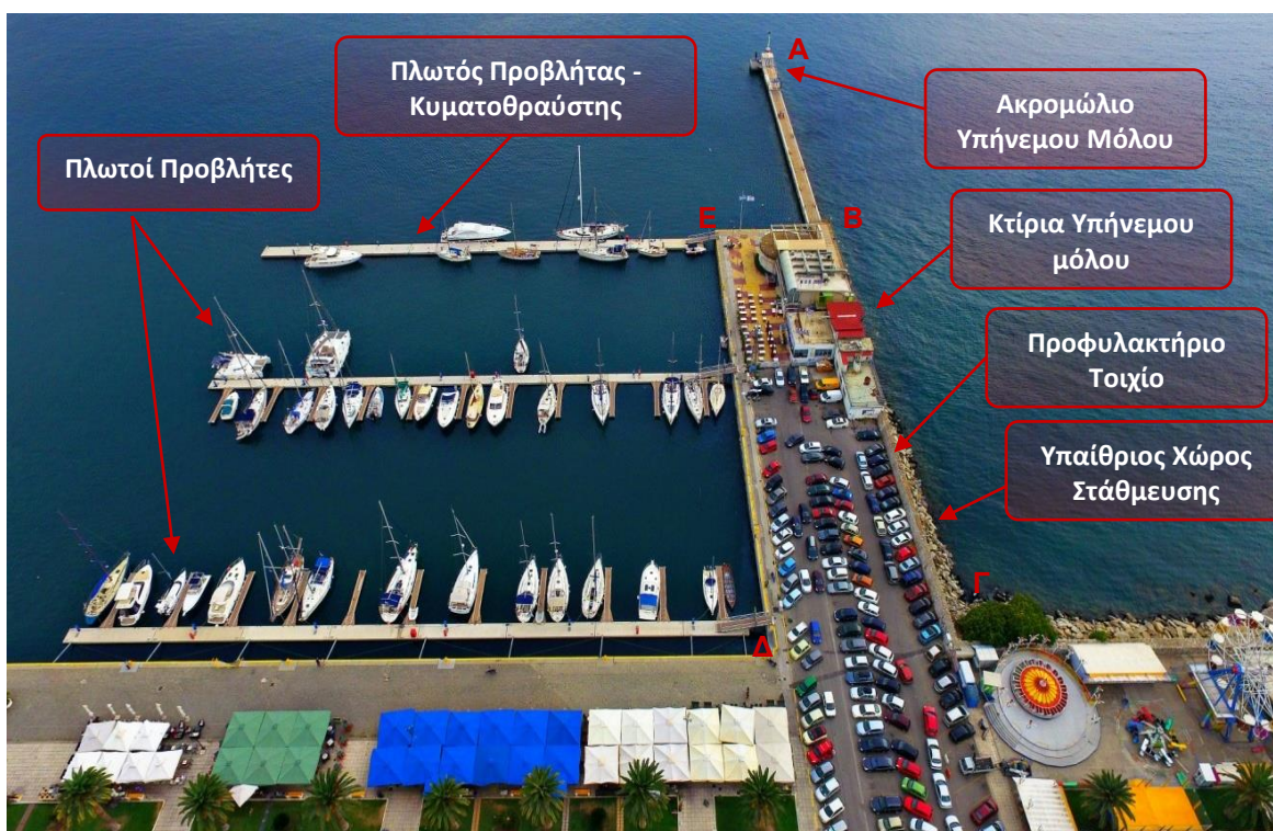
Εικόνα 4: Υπήνεμος μώλος - Πηγή: Αρχείο ΟΛΚ Α.Ε.
