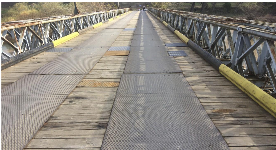
Σχημ. 2 Γέφυρα Μ. Δερείου
