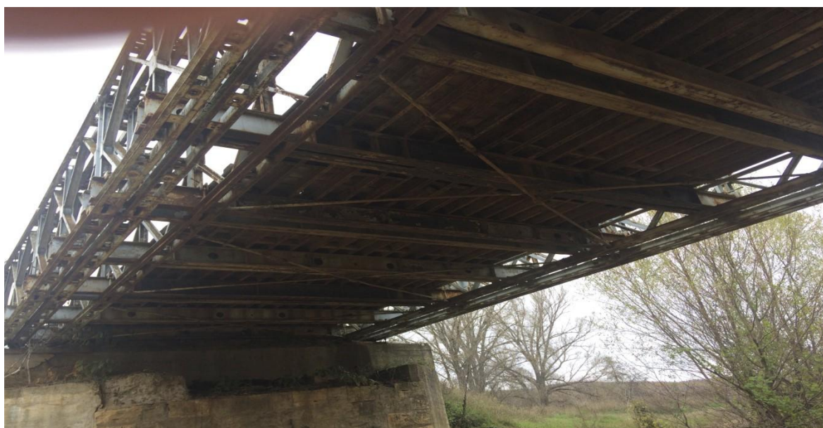
Σχημ. 3 Γέφυρα Μ. Δερείου
