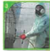
Προστασία κατά τη διάρκεια της εφαρμογής
