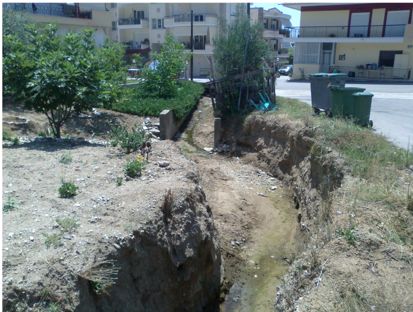
Χωμάτινη τάφρος με κατεύθυνση προς την υφιστάμενη κατασκευή ανάποδου Π
