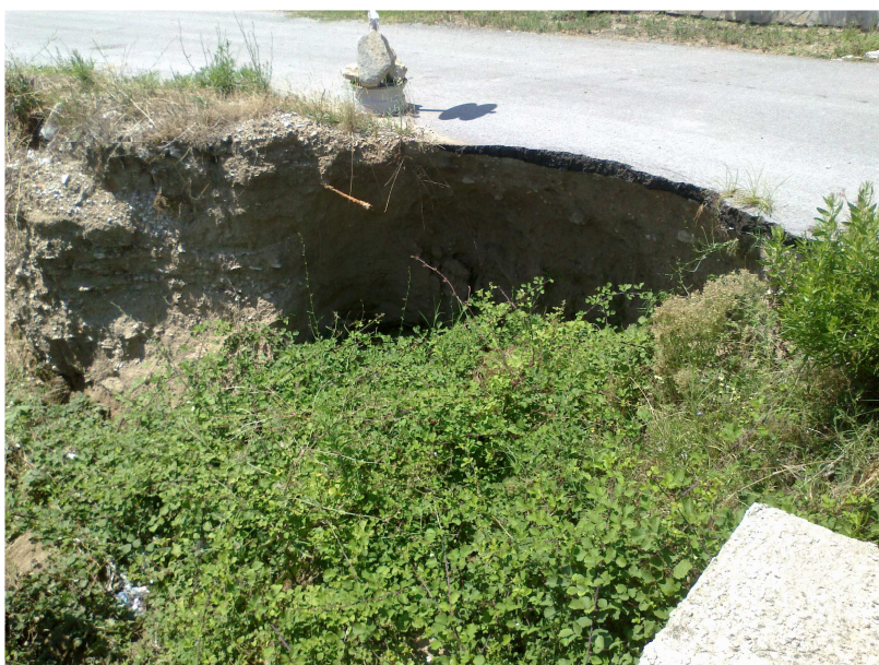
Καταστροφή του οδοστρώματος από την διάβρωση
